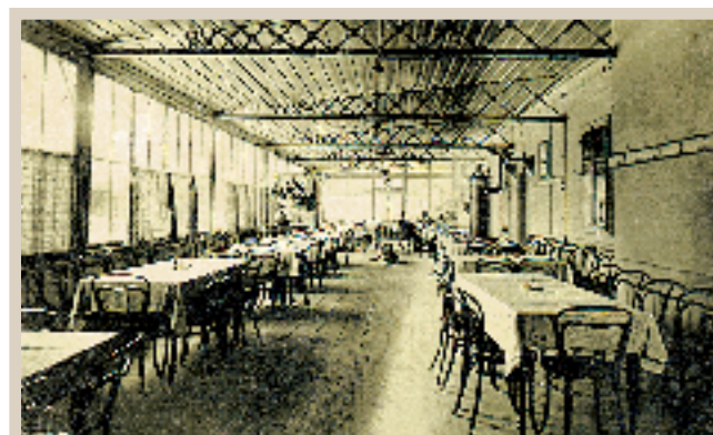
VERANDA (TERASA) BERĂRIEI „TREI STEJARI”, STR. TREI STEJARI 11, [1925]. TERASSE DER BRAUEREI „DREI EICHEN”, DREI-EICHEN-STRASSE 11. THE “TREI STEJARI” BEER-HOUSE TERRACE („THREE OAKS”), THE TREI STEJARI STREET, NO. 11.
